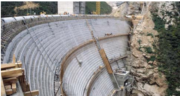
Wolwedans dam construction
